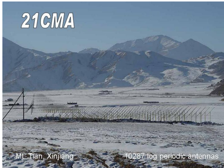
图 3 设在天山脚下的（红移的）21 厘米接收天线阵列。其上有 10,287 个对数周期天线。
