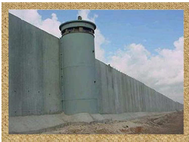
图1 以巴围墙，3.6米高。总长度预计为650公里。仍在建造中。
