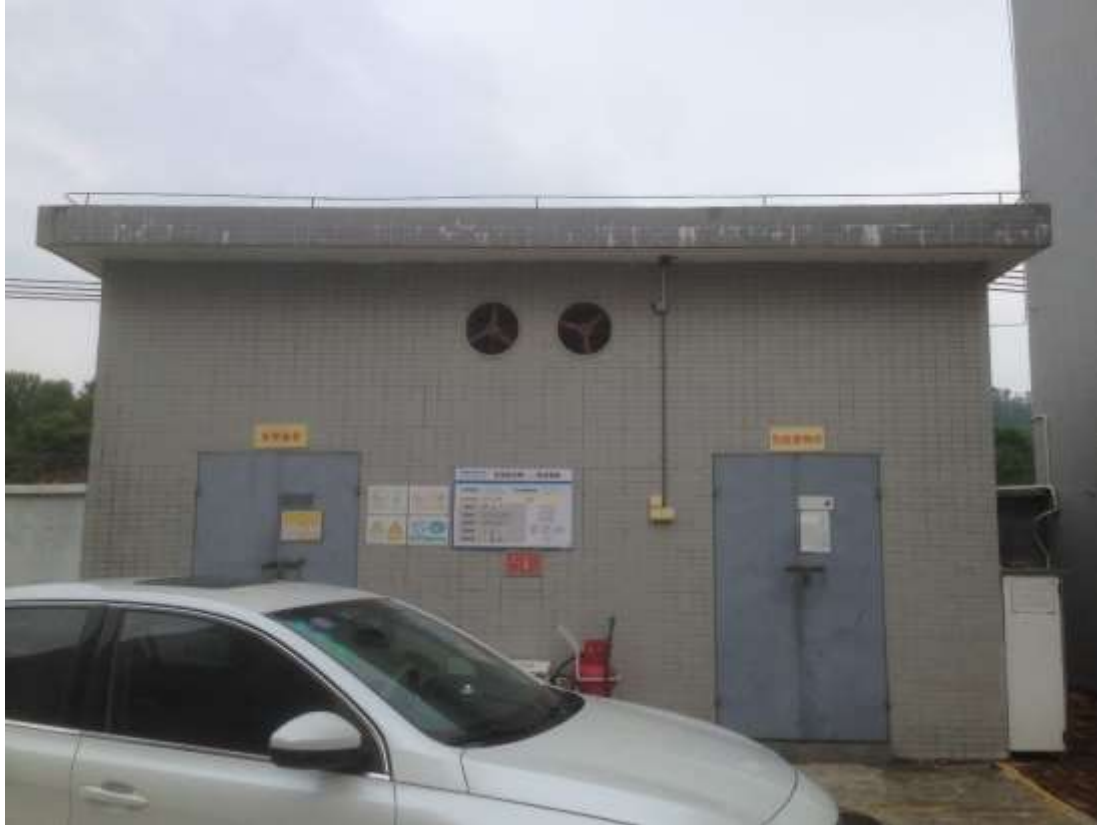
危险品，化学废弃物仓库
