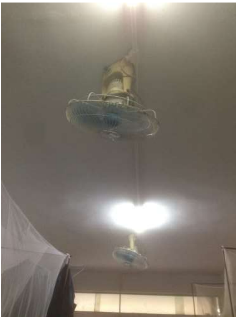
（装在宿舍天花板上的电风扇）
