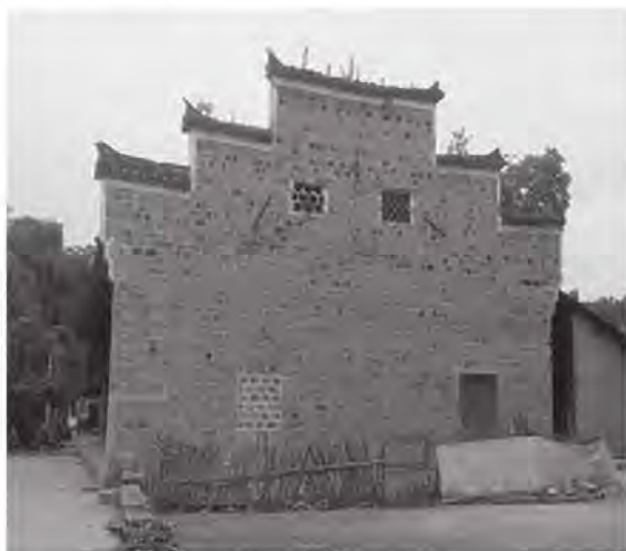
半邊街殘存的地主大院風火牆
