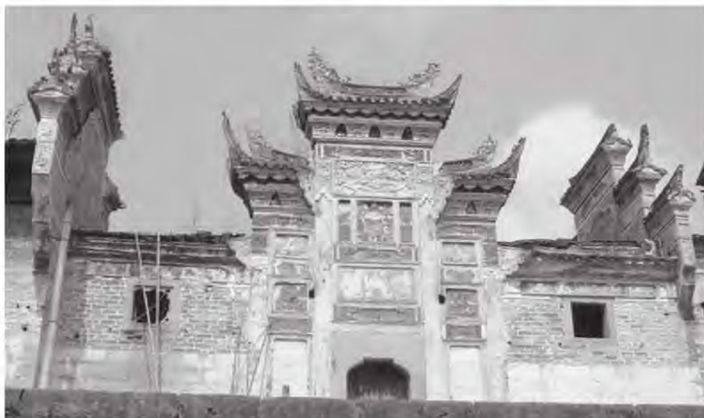
彭家大院殘存的一道側門
