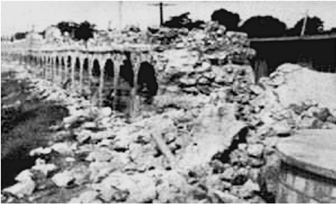
被震断的桥梁
