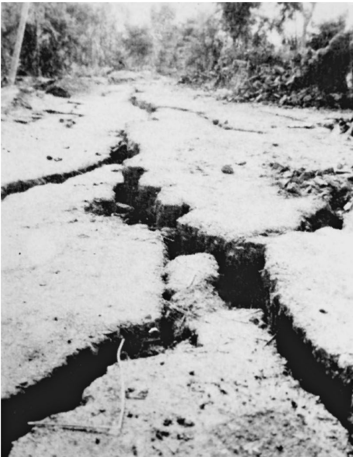
地震造成的地裂缝（王文澜 摄）
