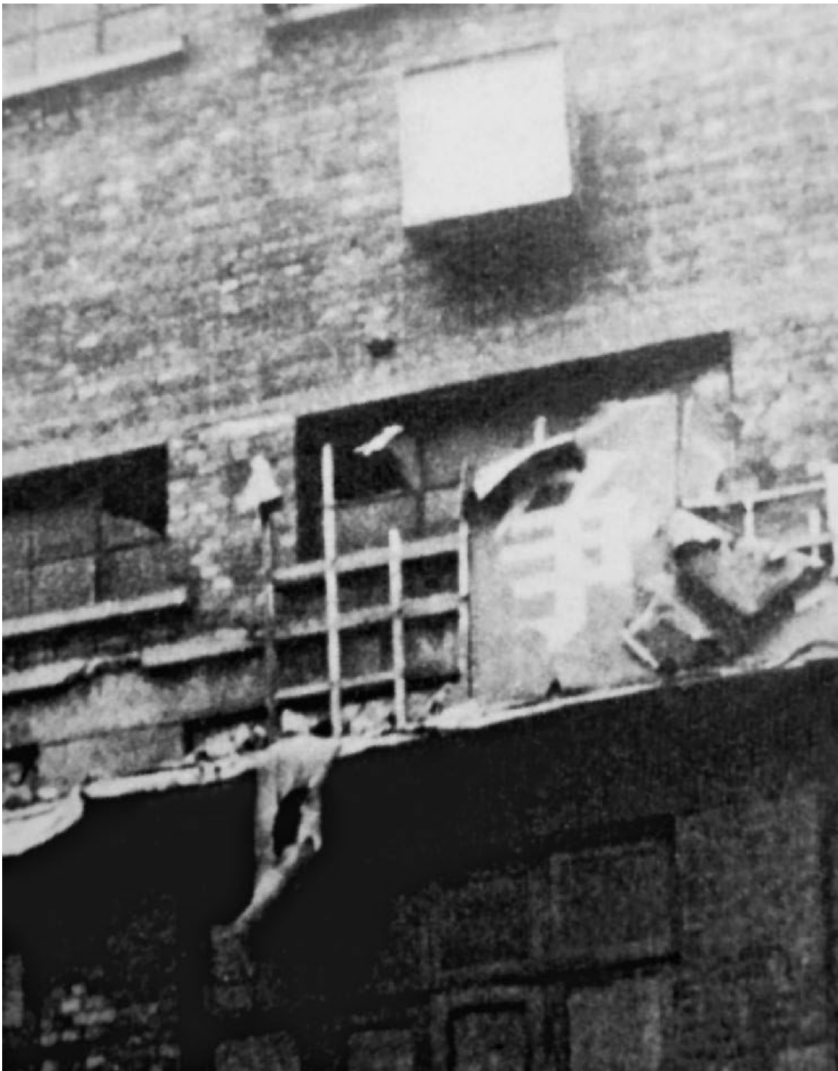
残破的建筑物上，残留着革命标语（李耀东 摄）
