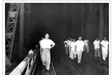
1958年黄河水灾期间，周恩来总理（中）查看济南泺口黄河铁路大桥。此次防汛工作相对成功[228]。
