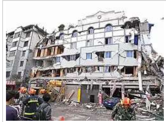
震後，一棟由當地政府於1999年興建來安置被拆遷居民的都江堰雲海汽修廠大樓，二樓佈滿細縫。此時尚有孕婦及老婦困於其中，也有多人已遭落下的建築材料砸死，攝於2008年5月14日。
