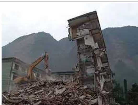
推土機正在推平一座倒塌的居民樓，攝於2008年5月19日。
