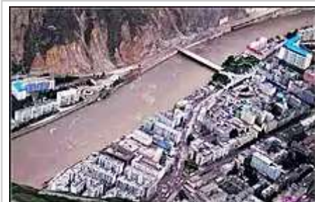
震后汶川县城的航拍图像，拍摄于2008年5月14日
