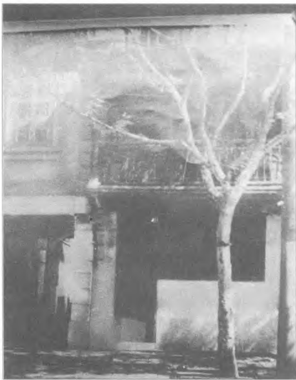
★ 毛泽民在上海新闸路培德里一幢石库门的房子里建立起秘密印刷发行机构，专门负责党中央文件和内部刊物的印刷和发行。图为设在上海新闸路培德里的中央出版发行部机关旧址
