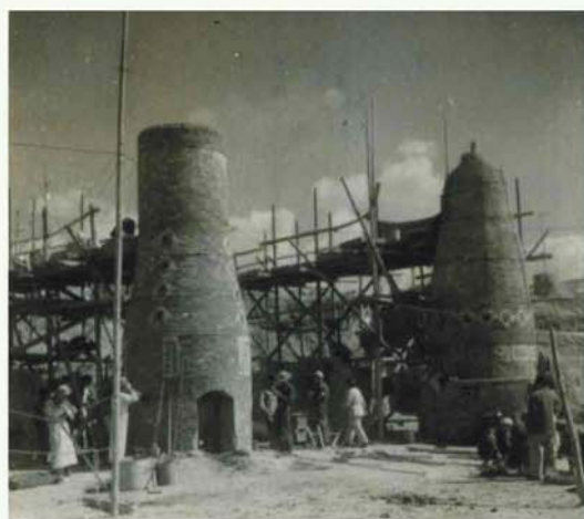
大炼钢铁时水库工地上的小高炉群
